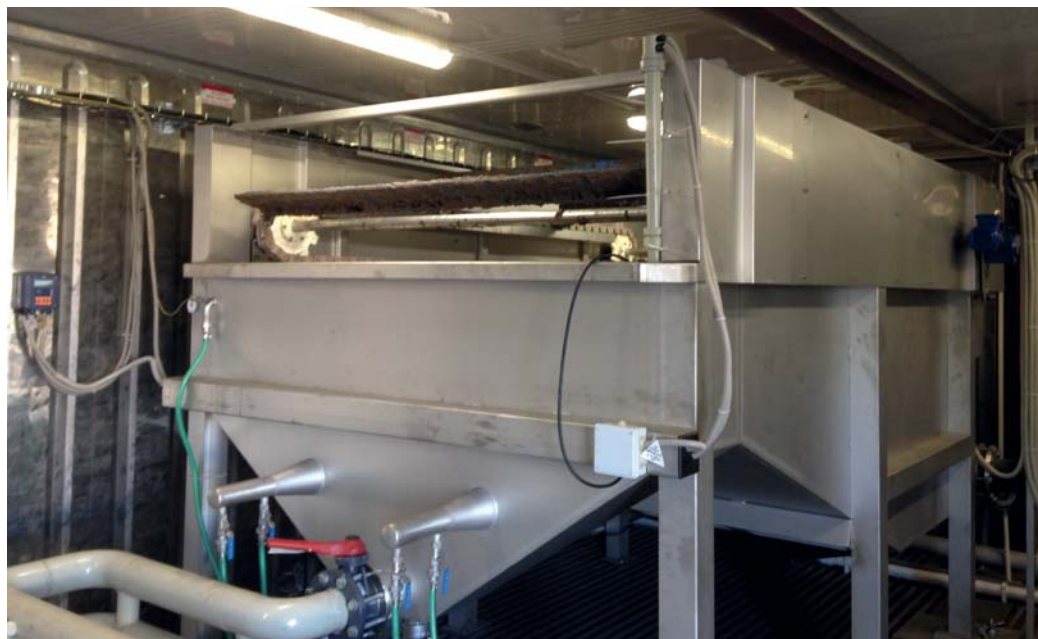
Рис. 7. Общий вид флотационной установки в контейнере на ЛОС ЗАО «Агротек Холдинг»
