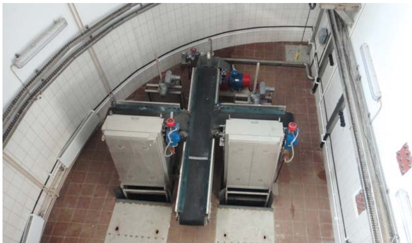
Рис. 7. КНС после реконструкции. ГРАБЕЛЬНОЕ ОТДЕЛЕНИЕ
