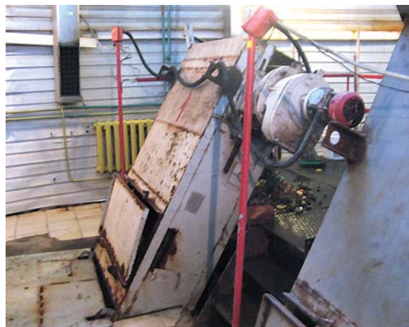
Рис. 3. КНС до реконструкции. Решётки
