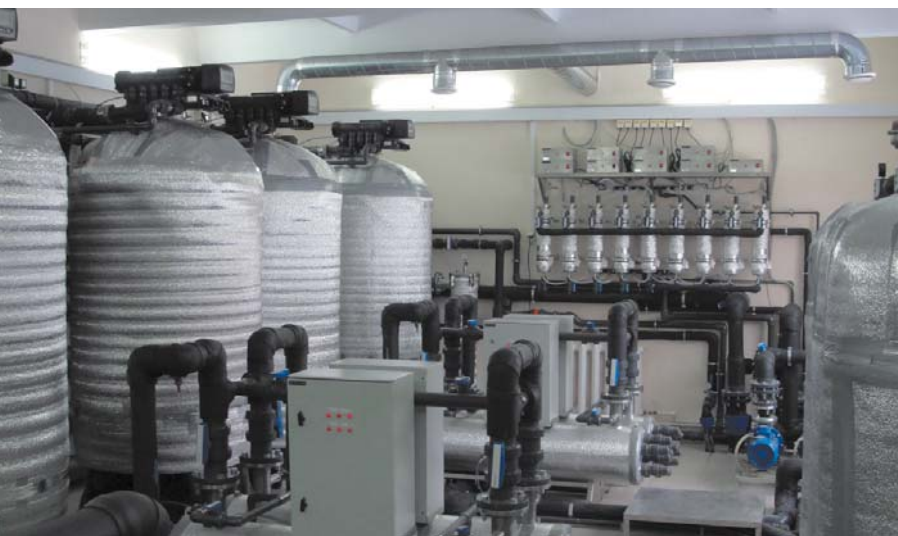
Рис. 4. УСТАНОВКА ПО ОЧИСТКЕ ВОДЫ ОТ ТРИХЛОРЭТИЛЕНА И ТЕТРАХЛОРЭТИЛЕНА ПРОИЗВОДИТЕЛЬНОСТЬЮ 60 м³/ЧАС (ВОДОКАНАЛ Г. ТРОИЦКА)
