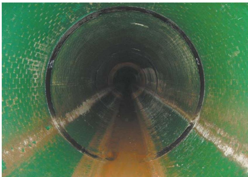
**ГОТОВЫЙ ТРУБОПРОВОД С ПОЛИЭТИЛЕНОВОЙ ФУТЕРОВКОЙ**
