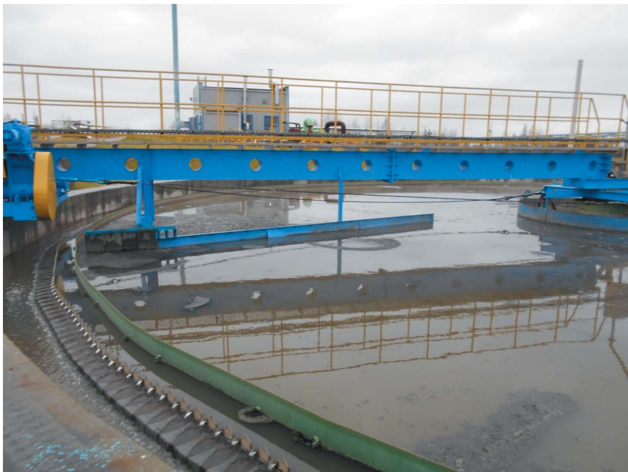
Рис. 1. Первичный отстойник, в котором происходит процесс «дозревания»
