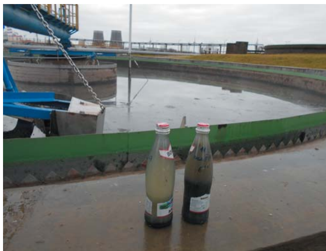
Рис. 2. Пробы осадка из придонной части первичного отстойника: до откачки осадка (справа) и после откачки (слева)
