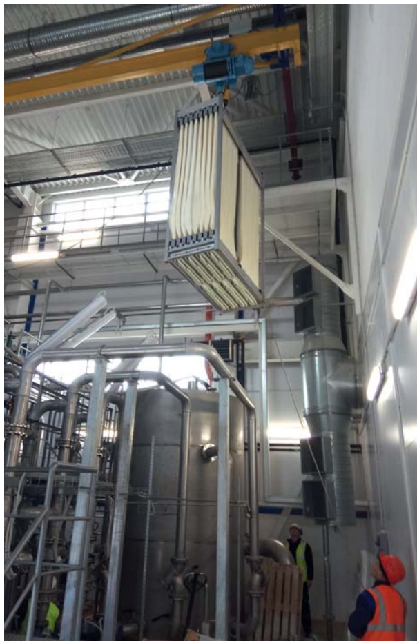
Рис. 11. Монтаж мембранных каскетов на ЛОС ООО «Пепсико Холдингс», г. Домодедово
