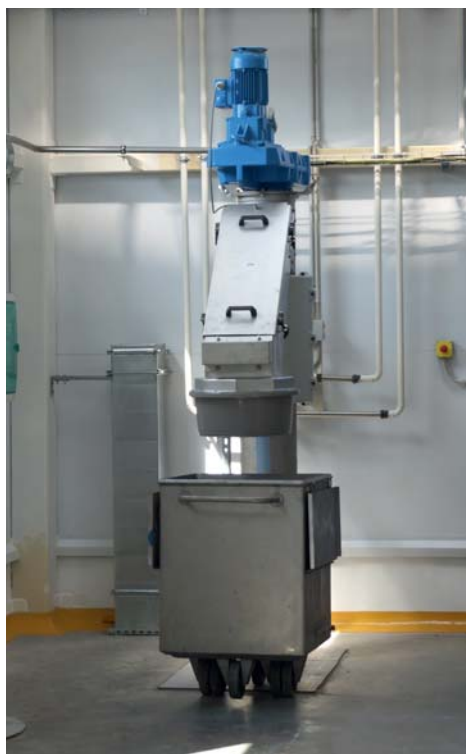
Рис. 7. ВЕРХНЯЯ ЧАСТЬ ВЕРТИКАЛЬНОЙ ШНЕКОВОЙ РЕШЕТКИ
