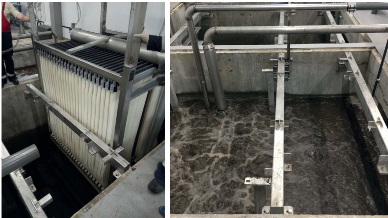
Рис. 1. Монтаж мембранных кассет и работающие резервуары на ООО «Тамбовская индейка»
