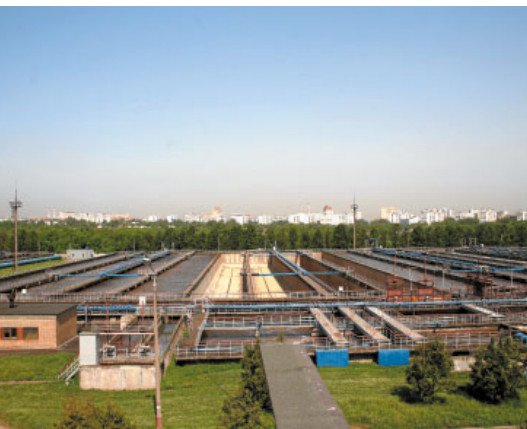
Аэротенки старых Люберецких очистных сооружений, на базе которых в 1998–2001 гг. был реконструирован опытно-промышленный блок (аэротенки №№ 13–15)
