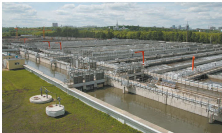
Один из двух реконструированных блоков Ново-Курьяновских очистных сооружений (в сумме 1,2 млн м 3 /сутки) – самые крупные ОСК в России, работающие с удалением азота и фосфора
